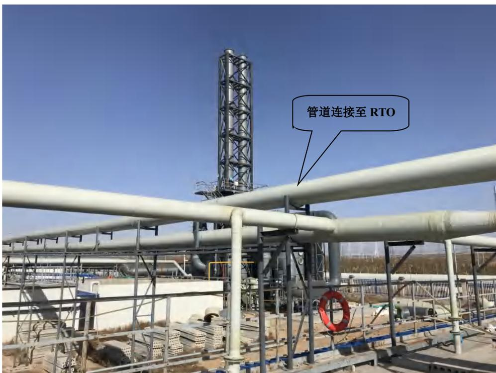
污水处理站废气通过管道连接至 RTO 焚烧装置处理
